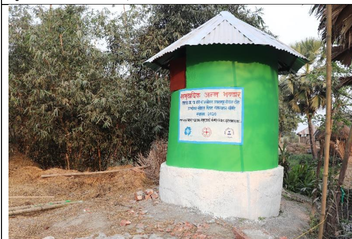
जहदा गा.पा. ५ सोहल टोलमा निर्माण गरिएको सामुदायिक अन्न भण्डार ।
