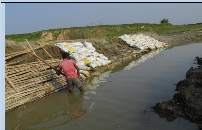
नदीकटान नियन्त्रणका लागि जलिया-३, बबियाविर्ता स्थित फुर्नाटोल नजिक कोचनी खोलामा बाँध निर्माण गरिँदै ।
